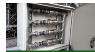
物理冷卻水系統除垢工程
